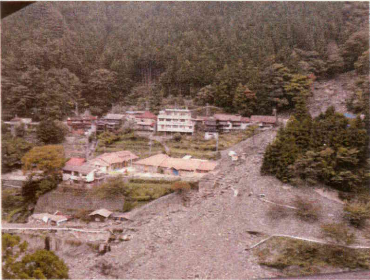
土砂に流された被災地の現在の様子
