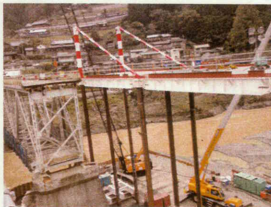
復旧工事の進む折立橋
